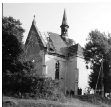
Kościół przed remontem 21.08.2003 r.
