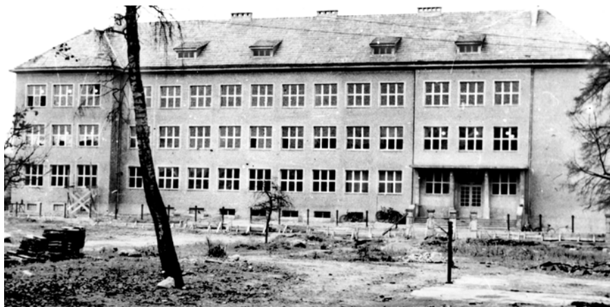
Obecny budynek ZS w chwili wybudowania
