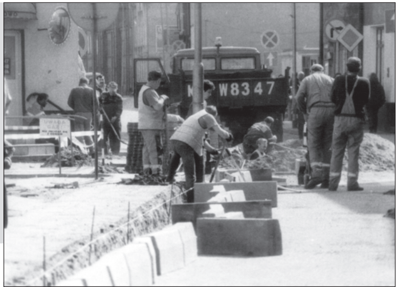
Najpierw to, co w ziemi. Potem krawężniki. Na koniec – asfalt.
