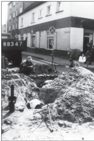
Wykopy na głównym skrzyżowaniu w Złocieniu
