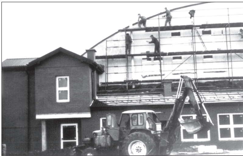
Prace wykończeniowe przy szczytowej ścianie hali
