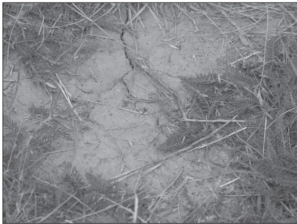
Spękana glina bocznego "boiska"
