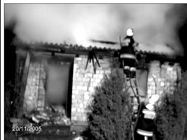
20.11.2005 - nocny pożar domku letniskowego w miejscowości Złocieniec. W wyniku pożaru budynek uległ całkowitemu spaleniu.
