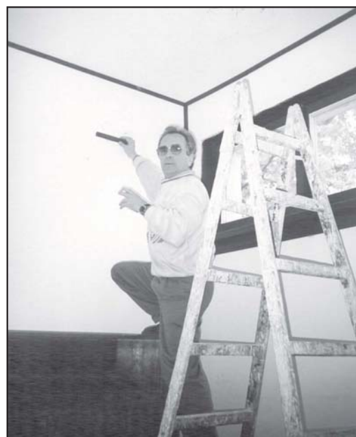
Prezes Klubu Wincenty Nowik przy pracach remontowo-budowlanych.
