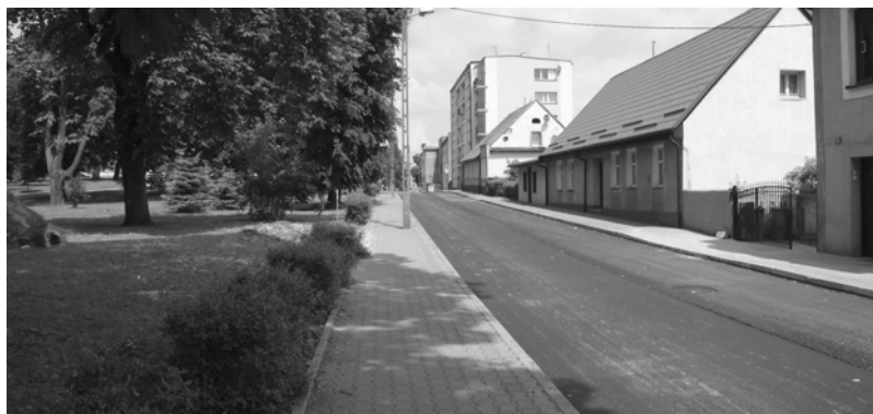
Foto 4: Kładąc chodnik na ul. Kościuszki wzdłuż parku można było pomyśleć o parkingach na całej długości parku, a chodnik położyć w parku, za drzewami. Jest on tu mało używany, a w parku chodziłoby się przyjemniej i bezpieczniej. Ten parking rozwiązałby problem dla całego centrum. Koszt przełożenia chodnika do wewnątrz parku i utwardzenia parkingu.
