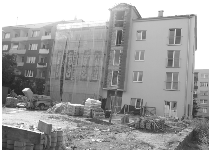
Budowa bloku mieszkalnego w Łobzie dobiega końca
